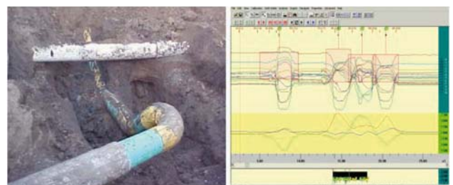
Serie di curve e controcure aventi raggio pari a 1,5D non conosciute. Questo Utensile ispettivo è in grado di riportare accuratamente gli angoli, il raggio, la direzione e la distanza tra una curva e l'altra.
